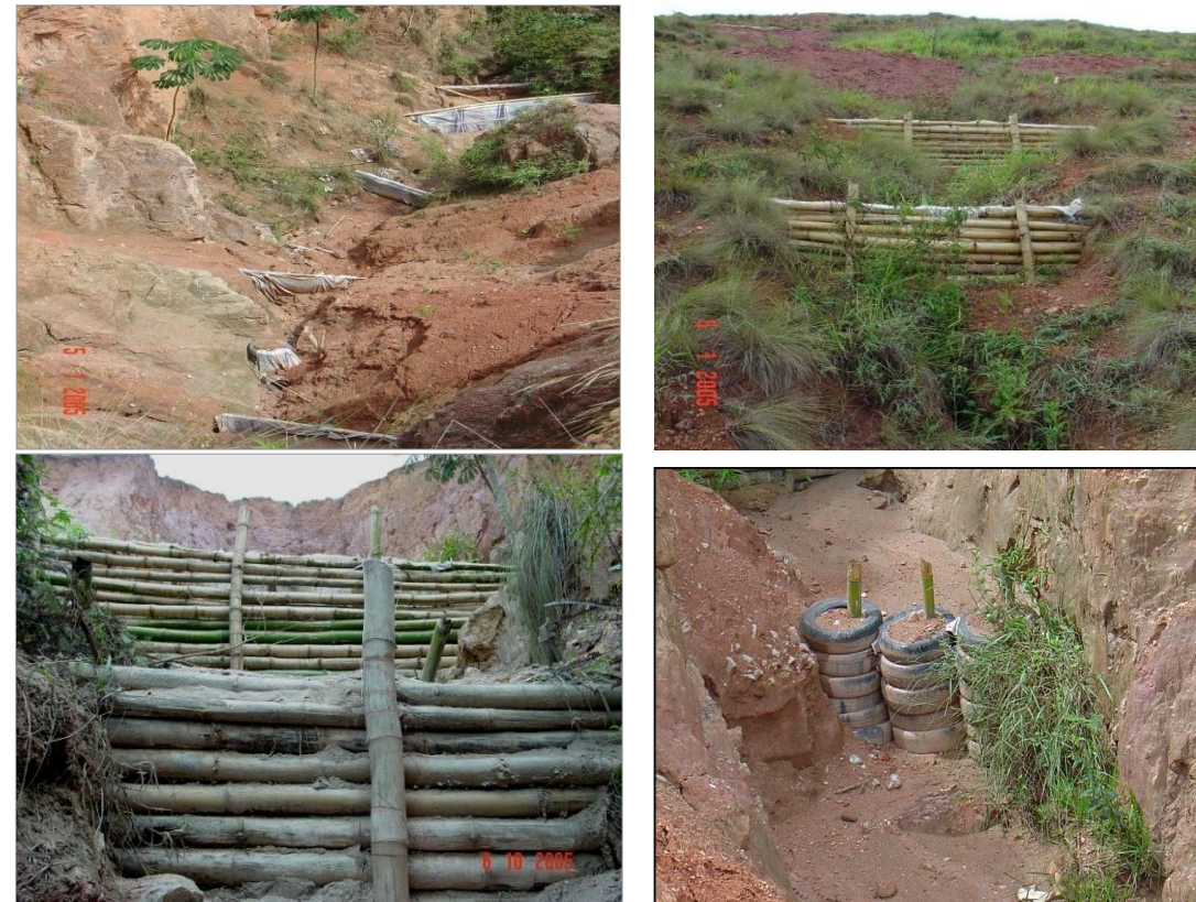
Paliçadas de bambu e pneus usados com sacos de rafia
