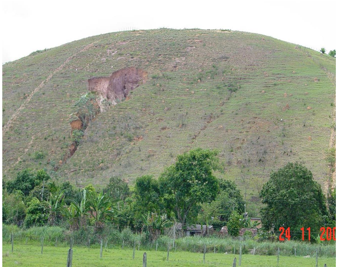
VER – Voçoroca em recuperação
